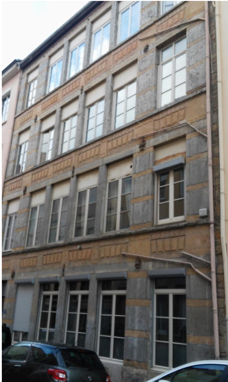
Vue d'ensemble ouest, façade
