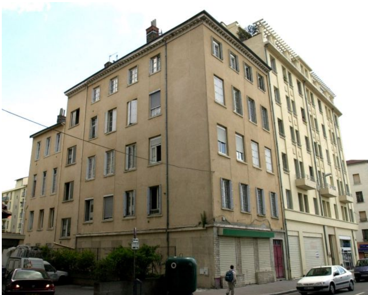
Vue générale, angle de la rue Casimir-Perier et du passage
