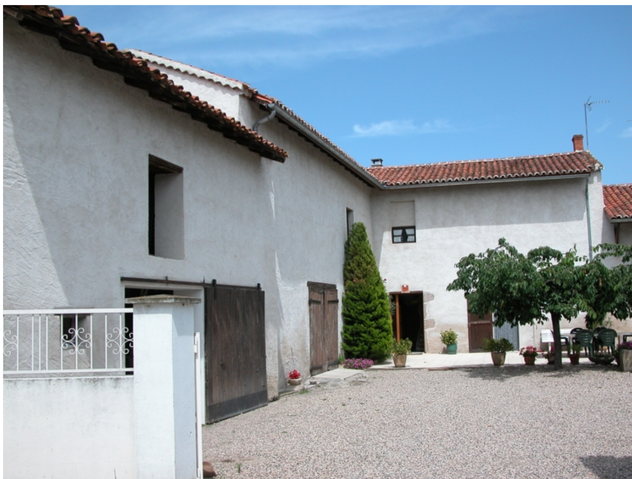
Vue intérieure de la cour : logis et retour nord, depuis l'ouest.
