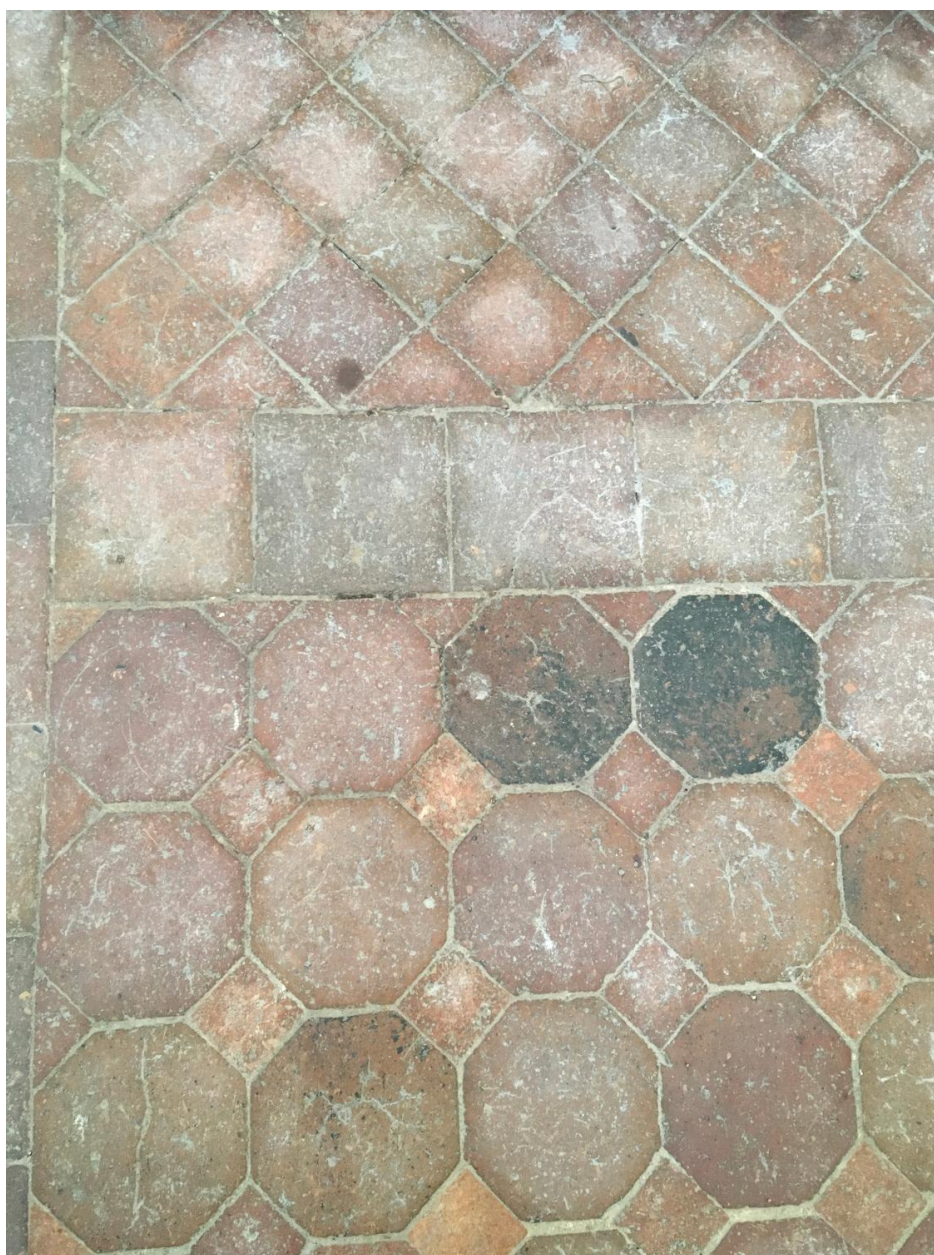
Nef : détail du revêtement de sol en tomettes
