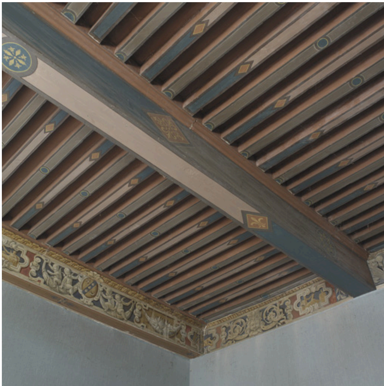
Vue intérieure, 1er étage : détail du plafond de la chambre d'apparat.
