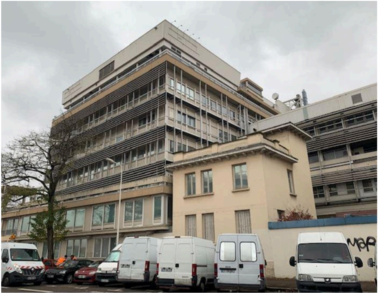
Petit bâtiment attribué à Tony Garnier (vers 1908-1910) architecte
