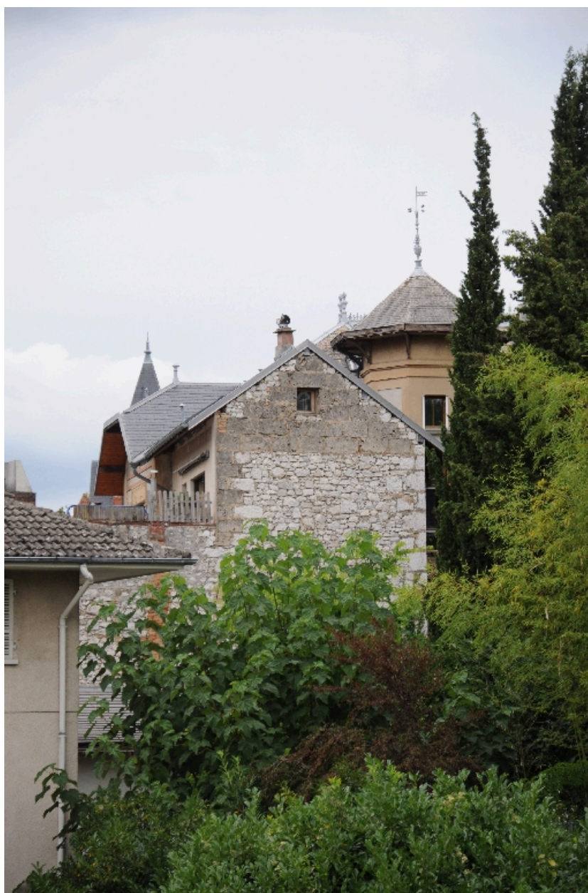
Mur pignon sud et tourelle
