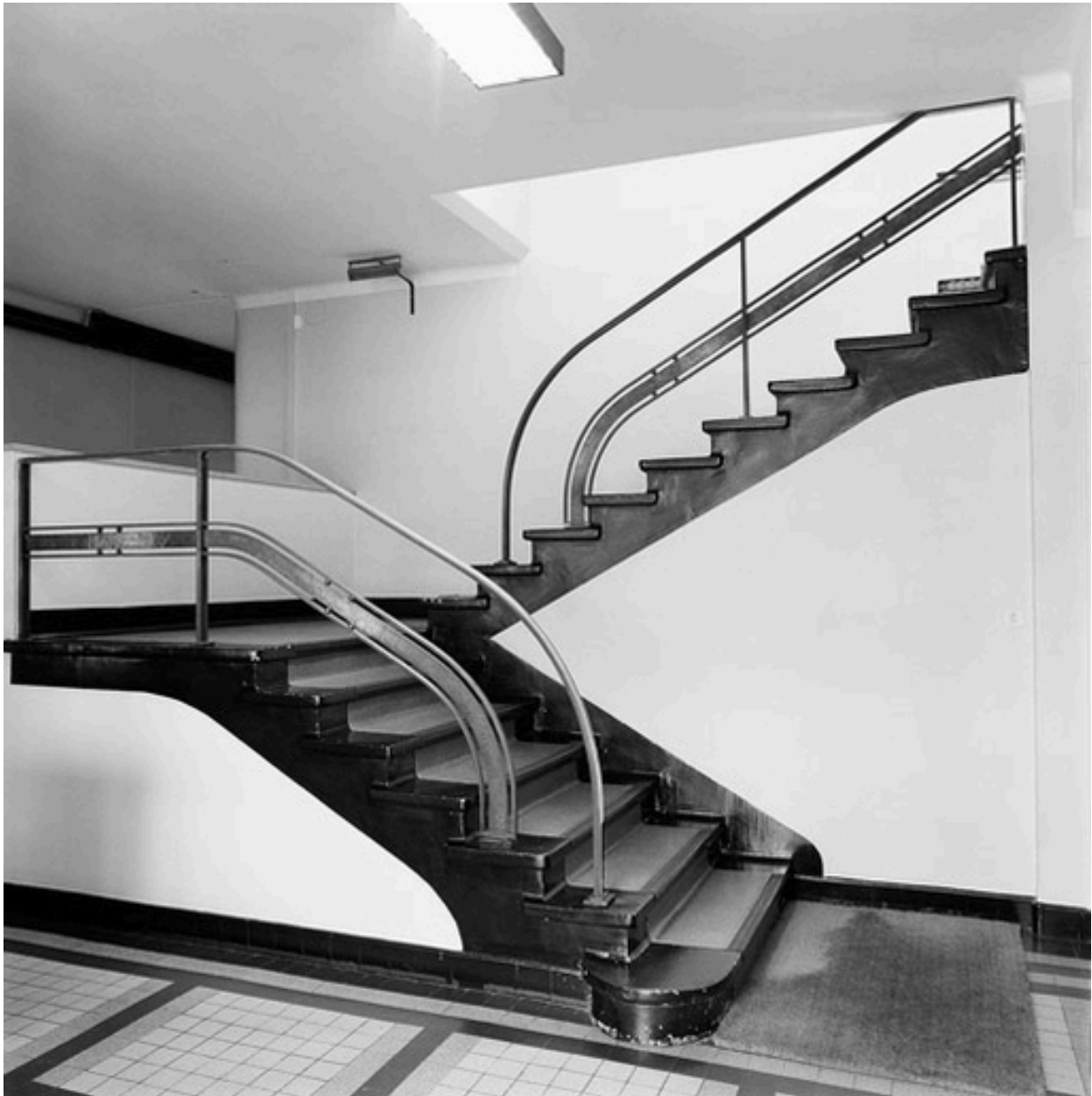
Vue sud de l'escalier du bâtiment directorial
