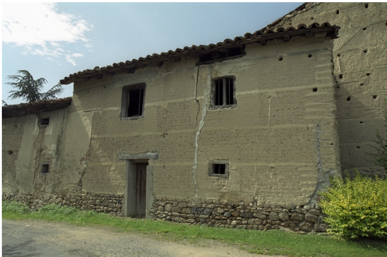
Marcoux, la Bruyette, ferme (1986 ZD 44). Élévation postérieure d'un bâtiment agricole (18e siècle).
