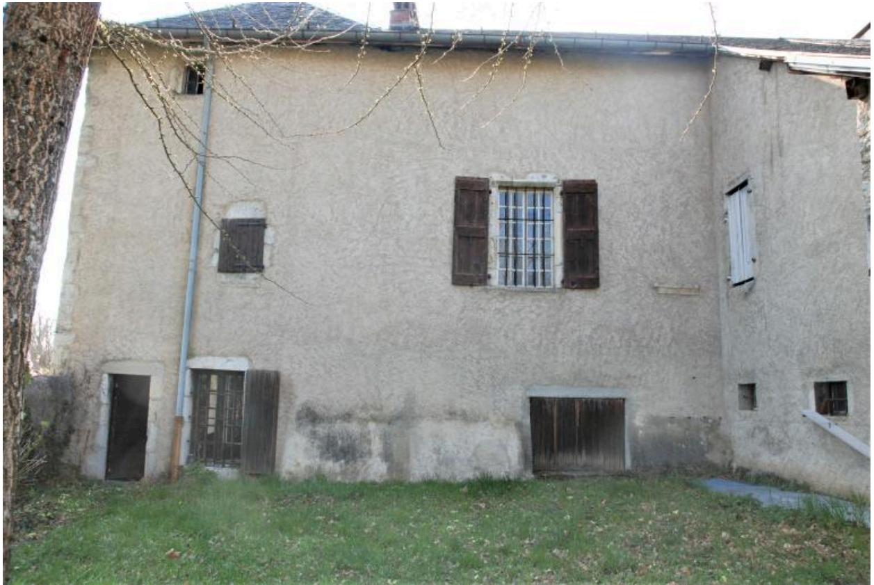
Façade arrière du corps de bâtiment principal (orientée à l'est)
