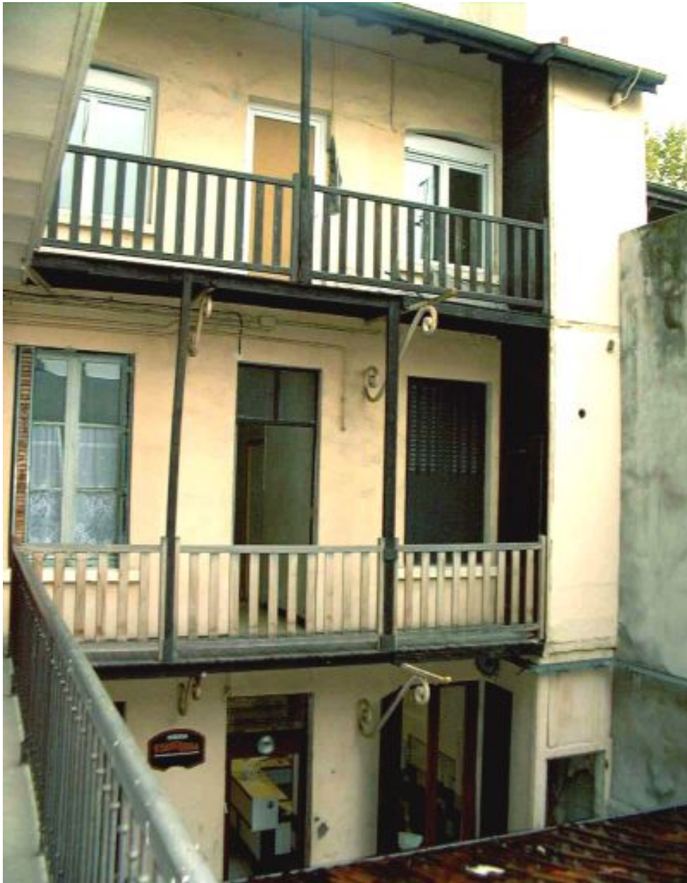
Détail des coursières sur la cour
