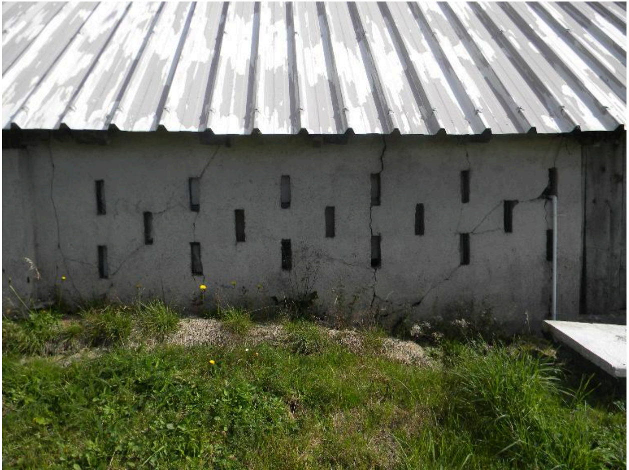
Vue du freidi en façade nord du bâtiment de l'ancienne étable.
