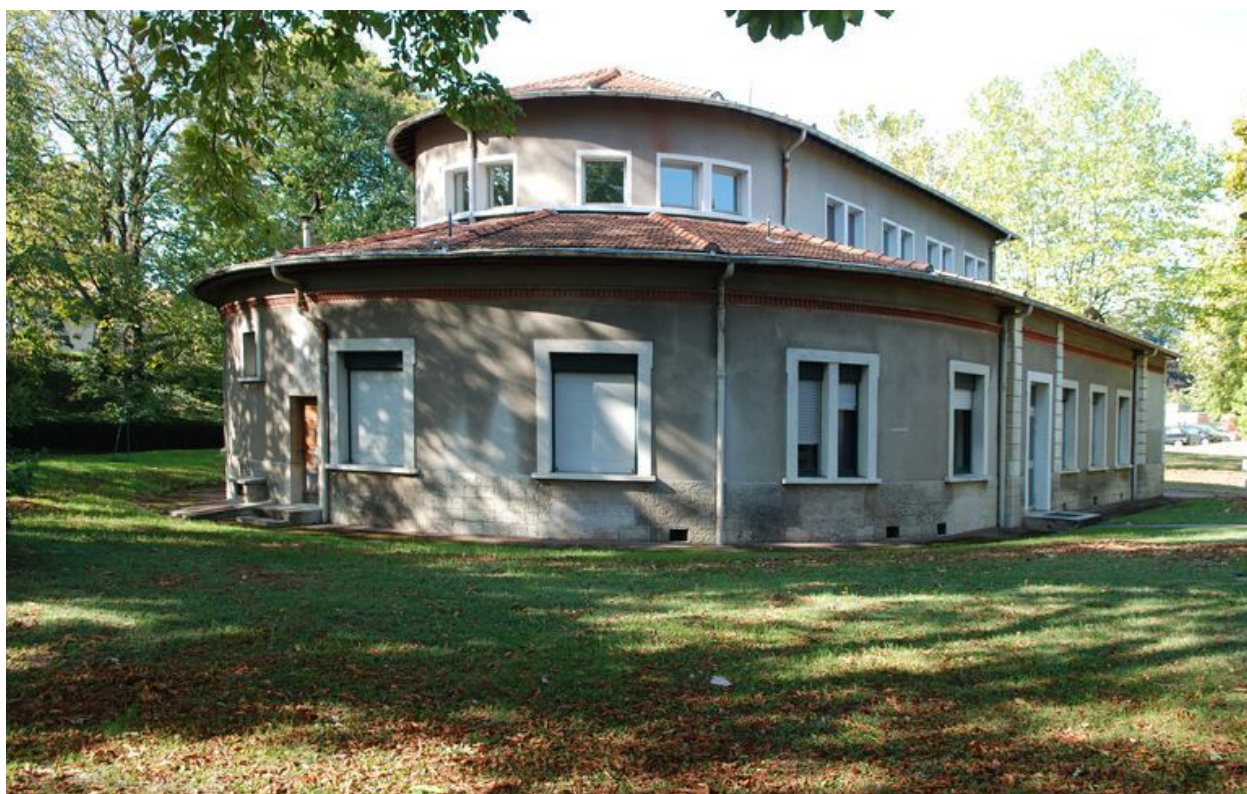
Vue du bâtiment 207 depuis le nord-est ; la partie semi-circulaire abritait des cellules
