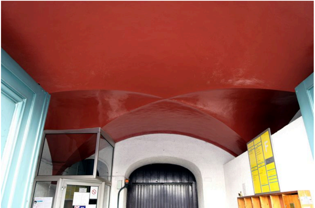
Passage cocher, détail de la voûte d'arêtes
