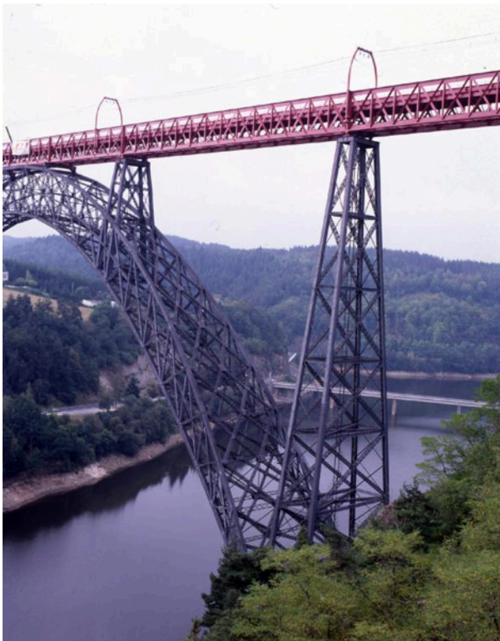
Détail de l'une des piles métalliques et du départ de l'arche centrale du viaduc.
