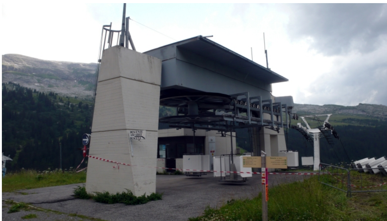
La gare supérieure de la télébenne des Grands Vans, depuis l'est
