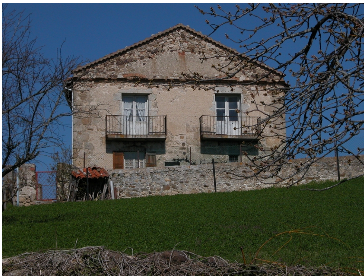
Vue d'ensemble de la demeure, façade latérale, depuis l'est.
