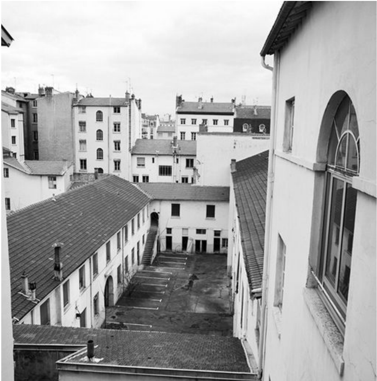
Cour 005, vue générale vers le nord
