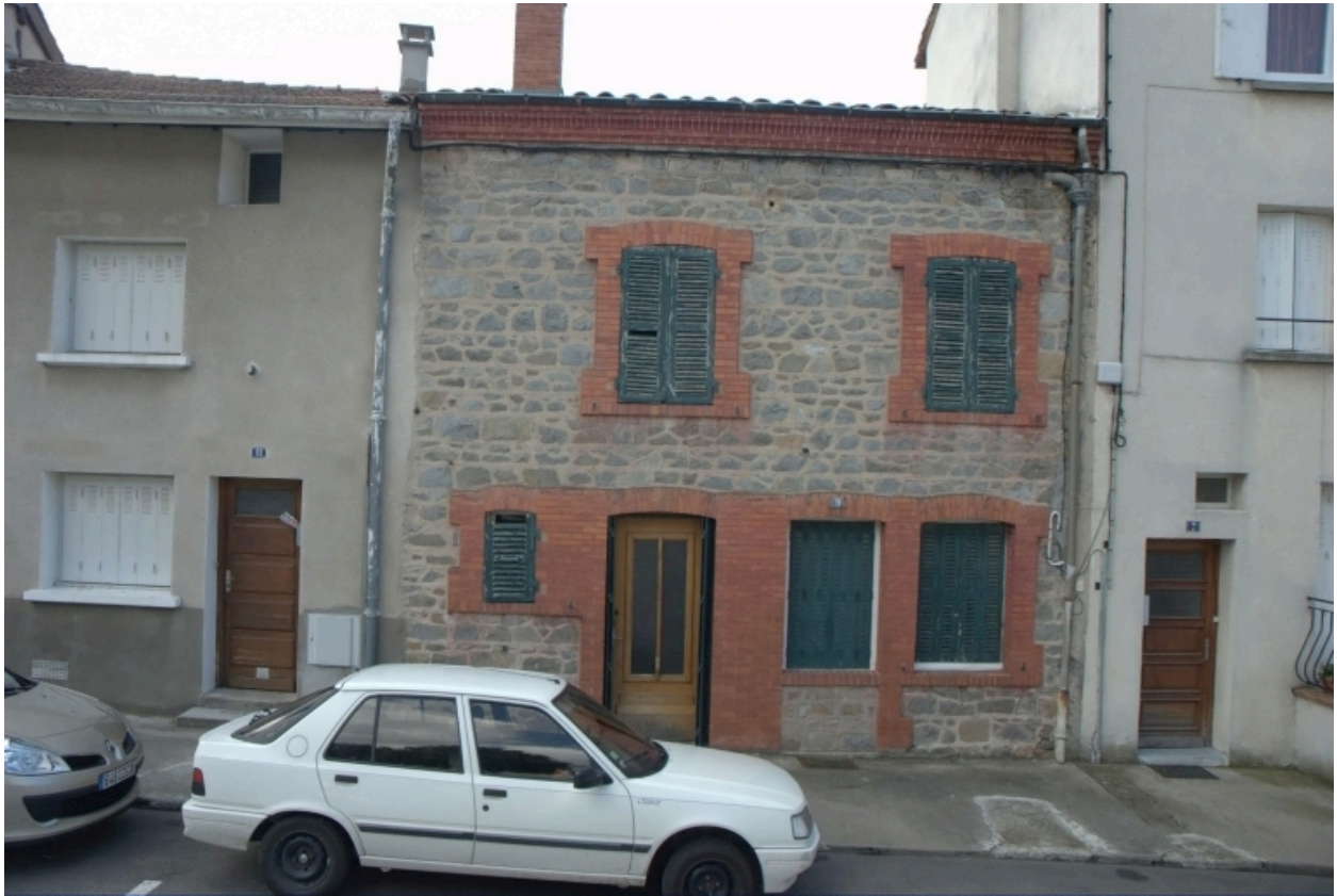
Îlot 3. Sordet (rue du) 09. Vue générale de la façade sur rue.
