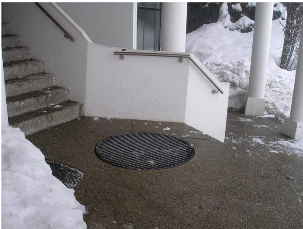
Le perron de l'entrée aval
