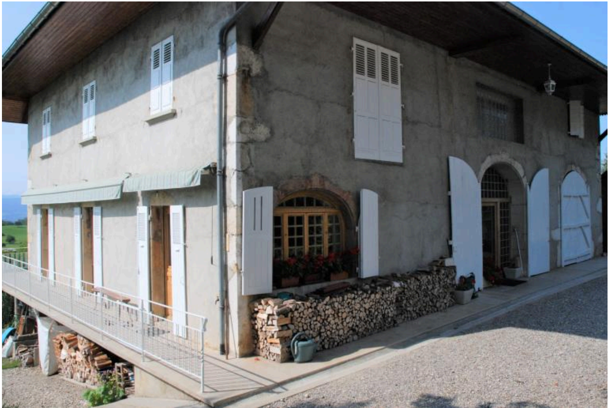
Viuz-Nord, C4 225, grange-étable, actuellement maison. Vue d'ensemble de trois-quarts avant gauche du bâtiment avec les ouvertures nouvelles de l'habitation.
