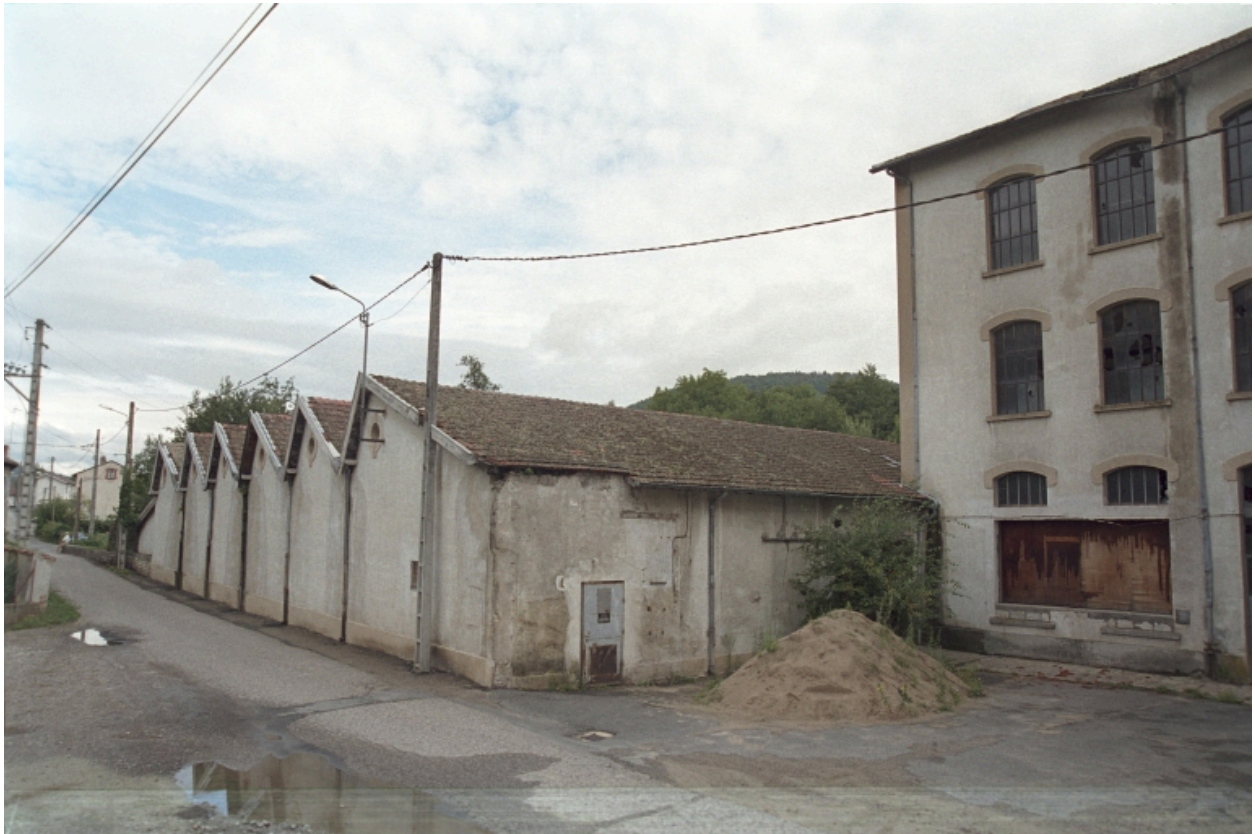
Vu d'ensemble des sheds des métiers à tisser de l'usine Giron.
