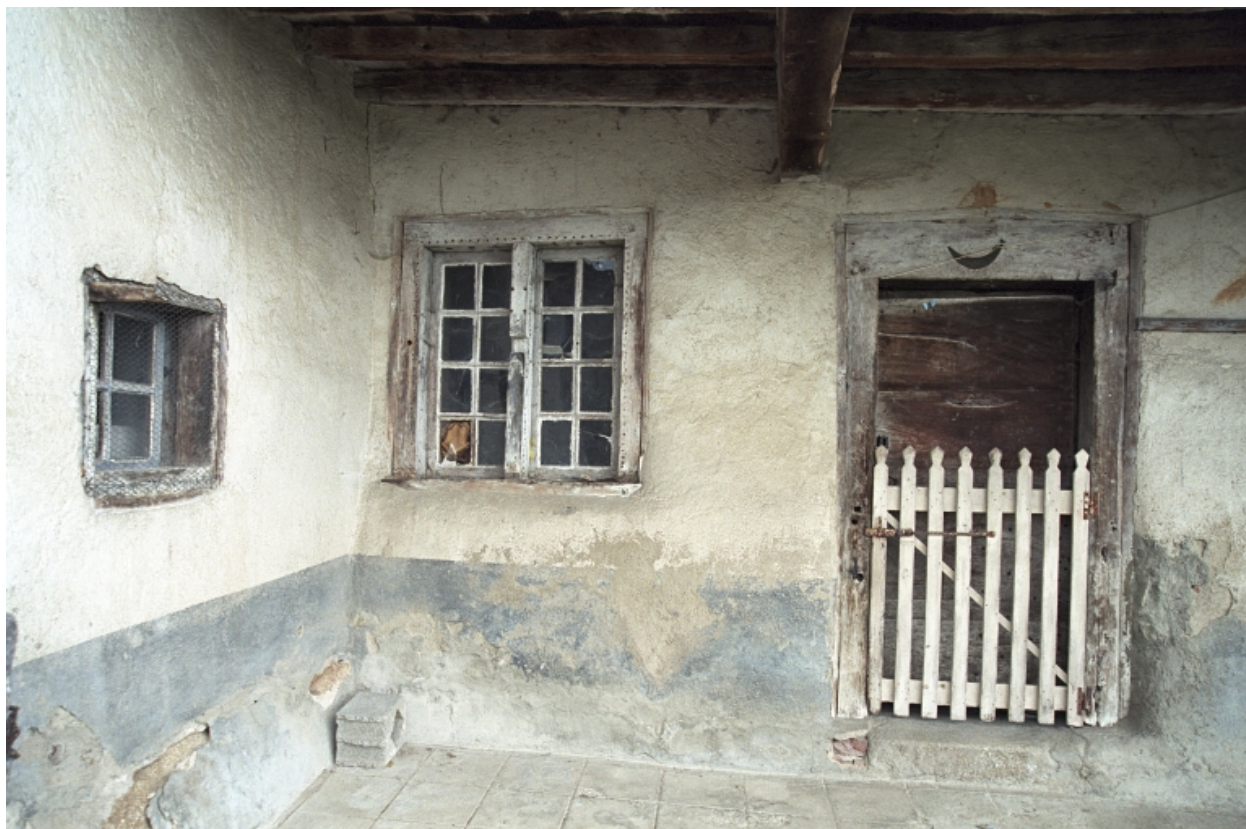
Premier logis, partie gauche de la façade antérieure.
