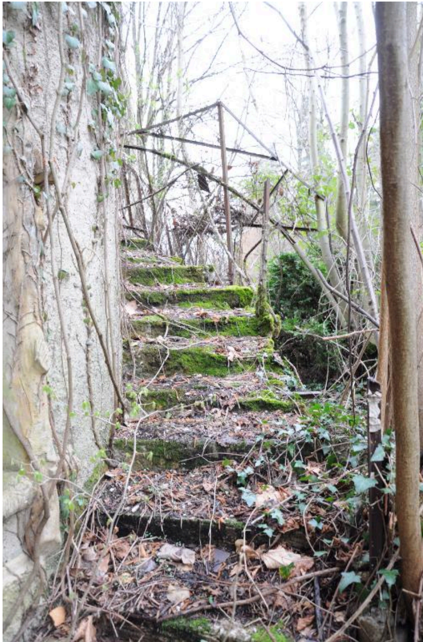
La tour ronde, ou pigeonnier, détail sur l'escalier extérieur
