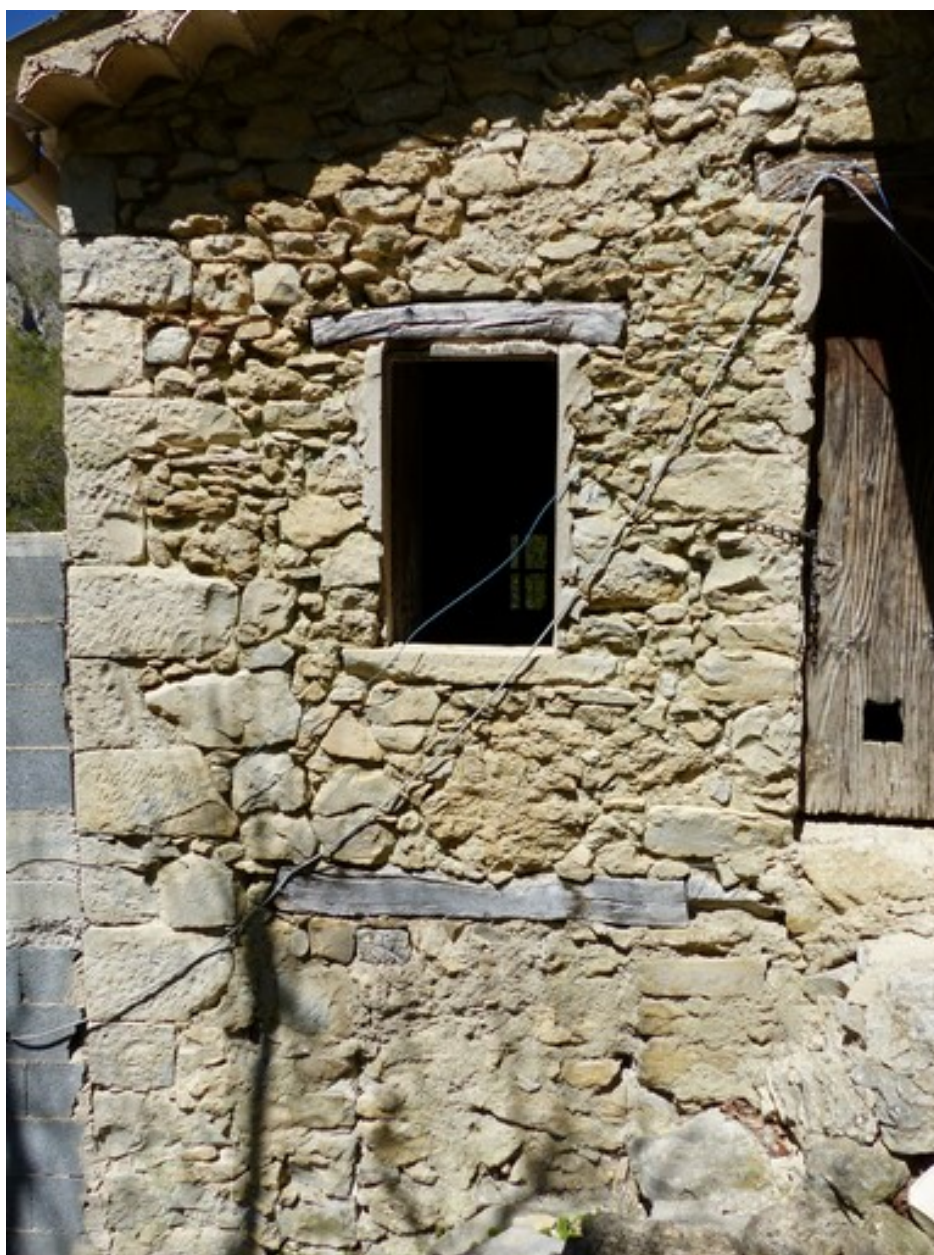
Partie ouest. Pignon sud, deuxième niveau. Fenêtre.
