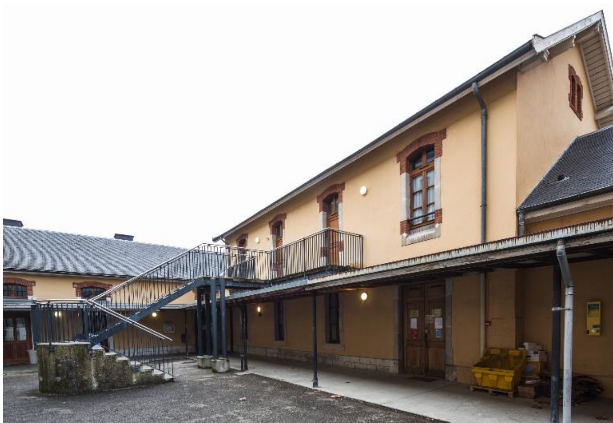
Cour nord : actuelle infirmerie.
