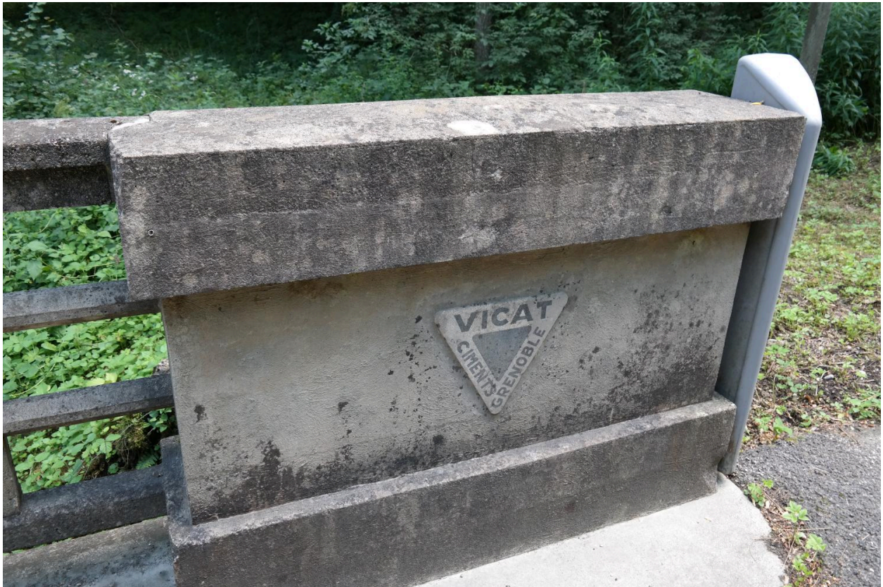
Pont du Parmand 1, détail d'une inscription sur garde-corps
