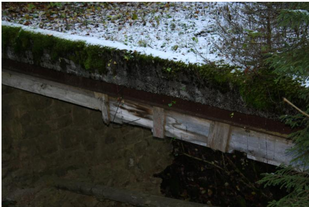
Vieux pont des Landoz, détails poutre acier et renfort bois
