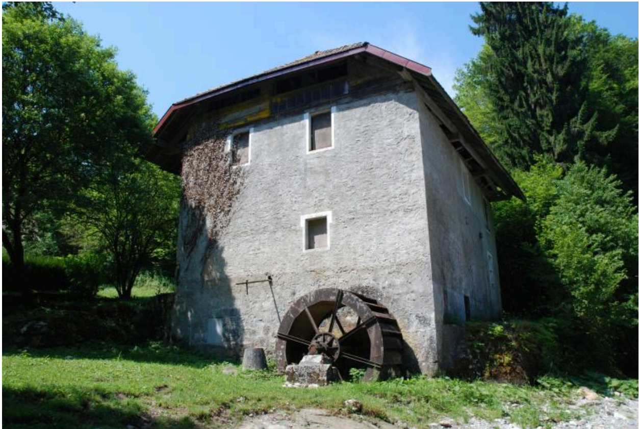
Vue du bâtiment principal, élévations est et nord.
