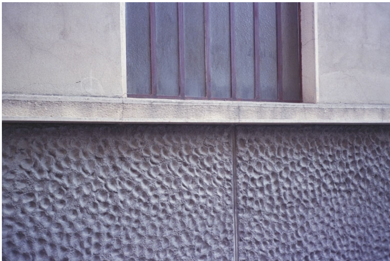
Vue sud détail façade
