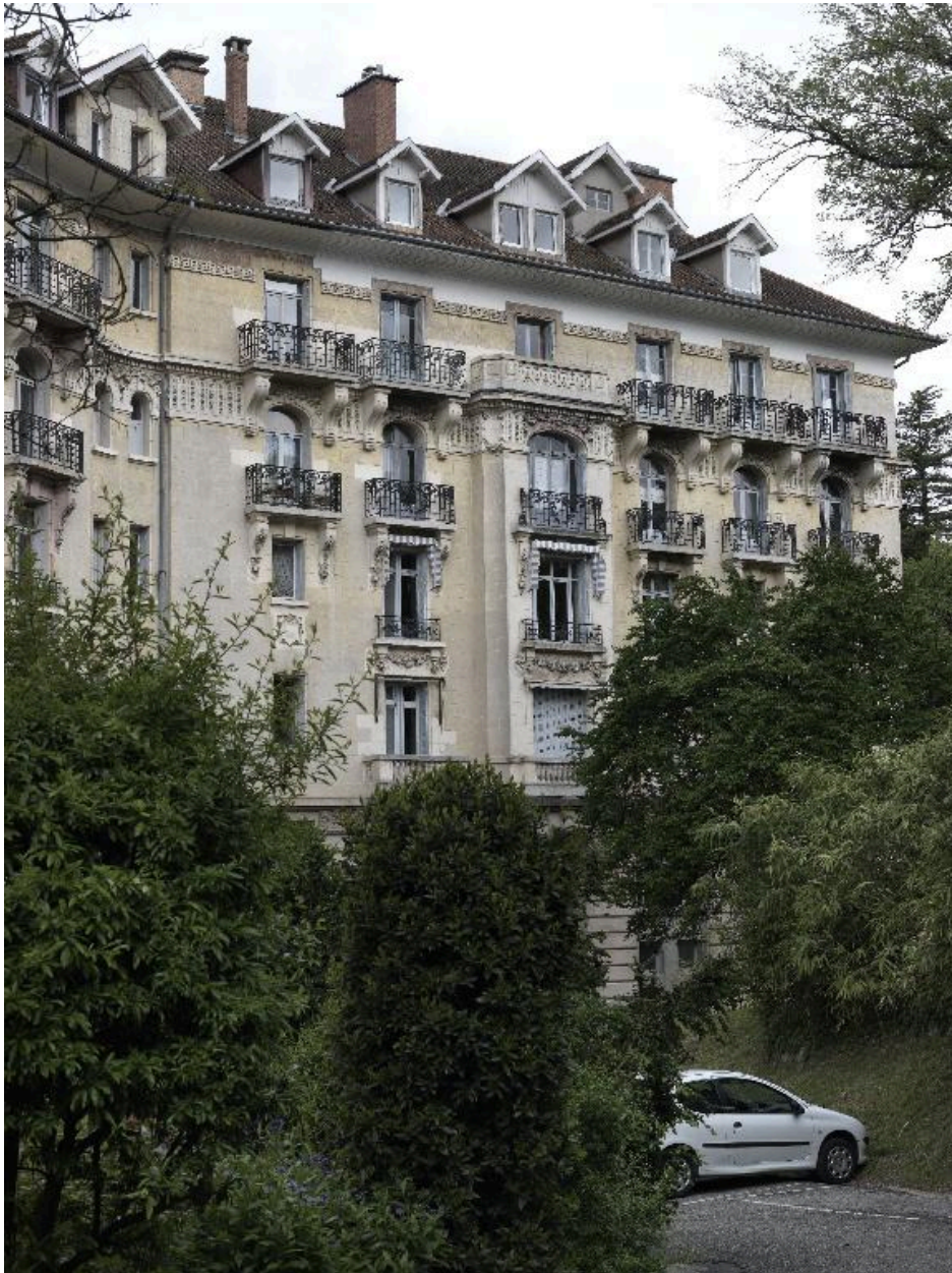
Façade sur cour: aile nord
