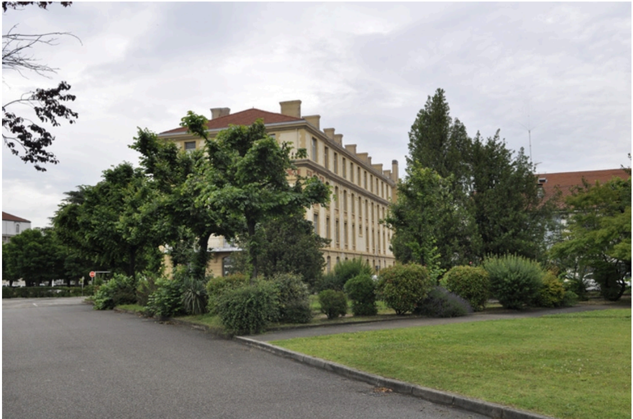
Bâtiment de 1916, pignon ouest et façade sud.
