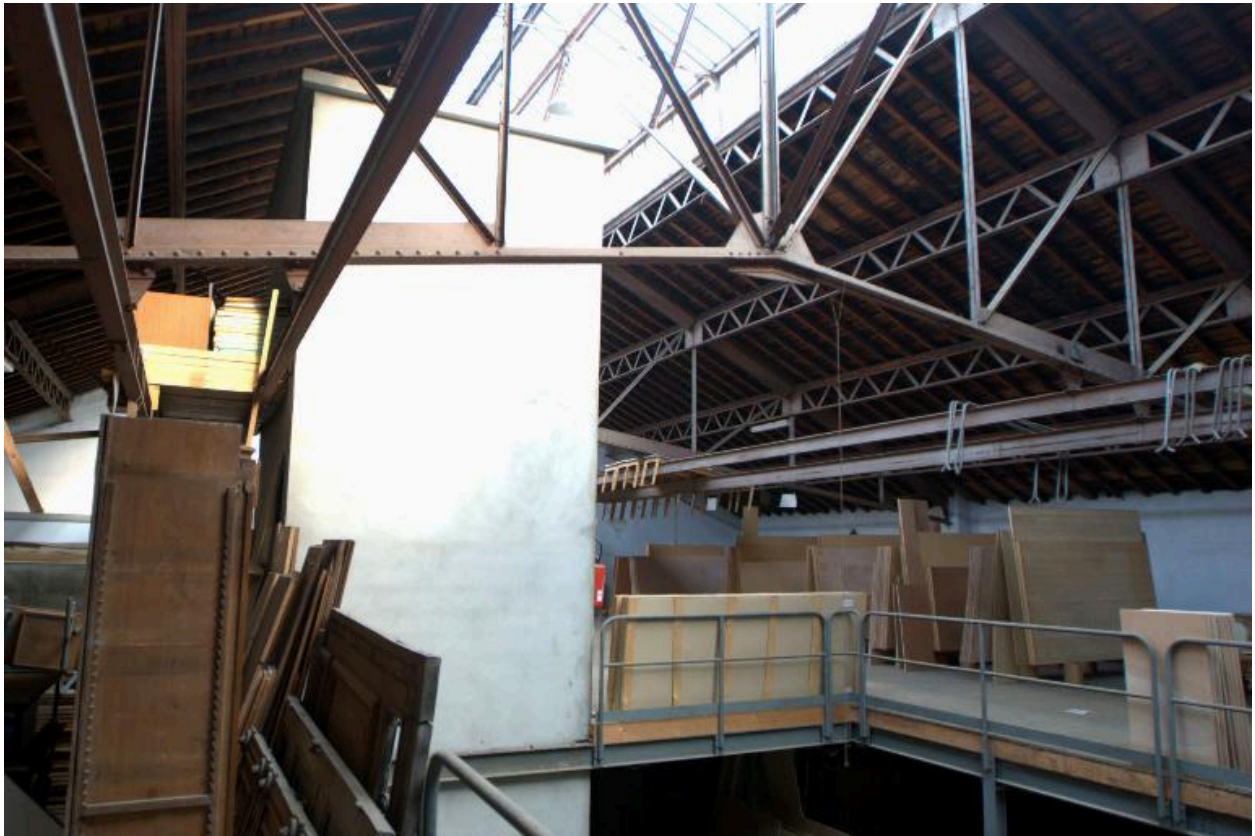
Atelier de menuiserie, mezzanine
