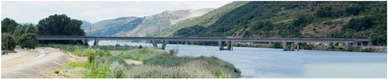
Vue panoramique, face amont (depuis le pont suspendu)
