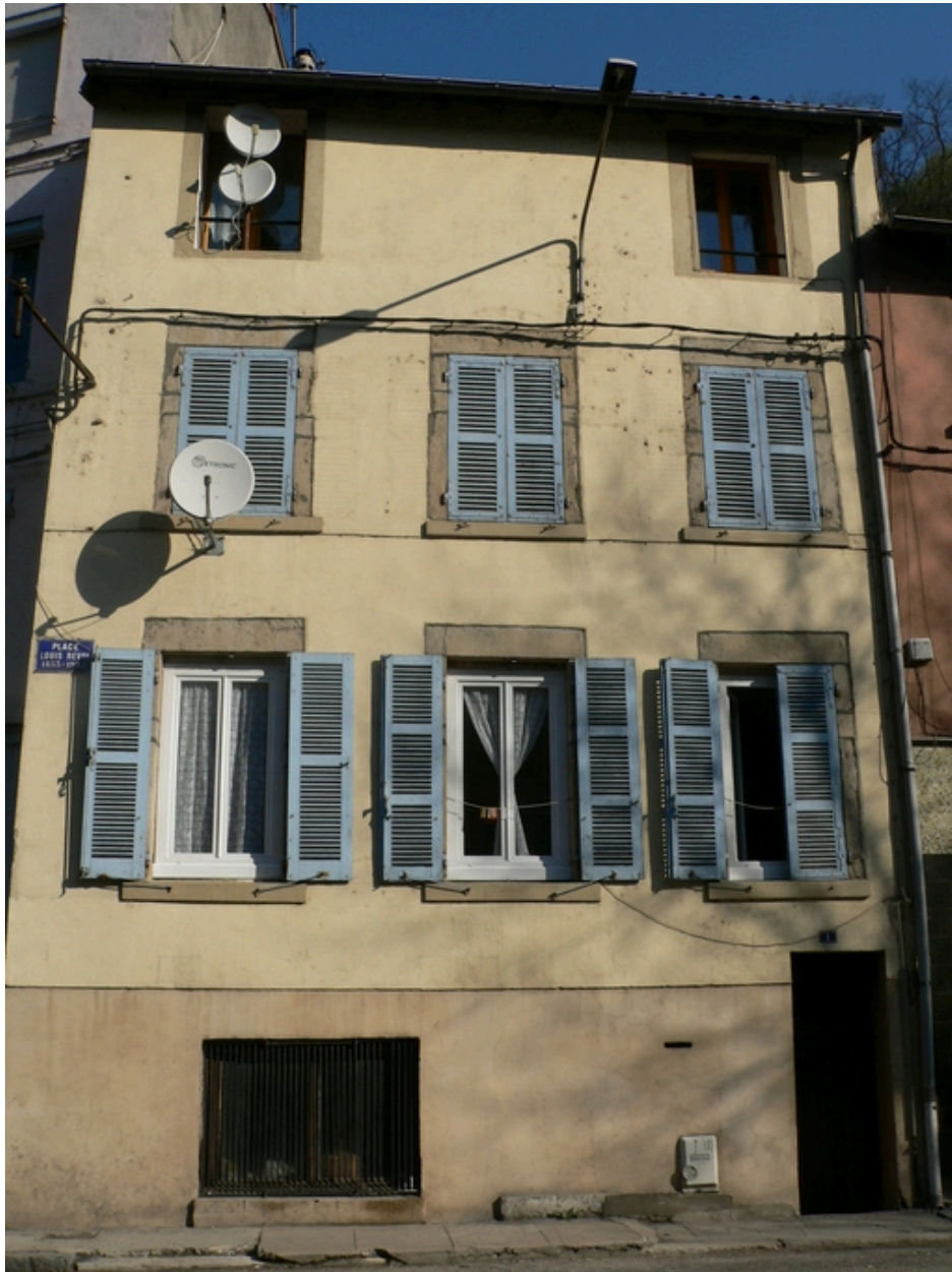
Façade principale sur rue
