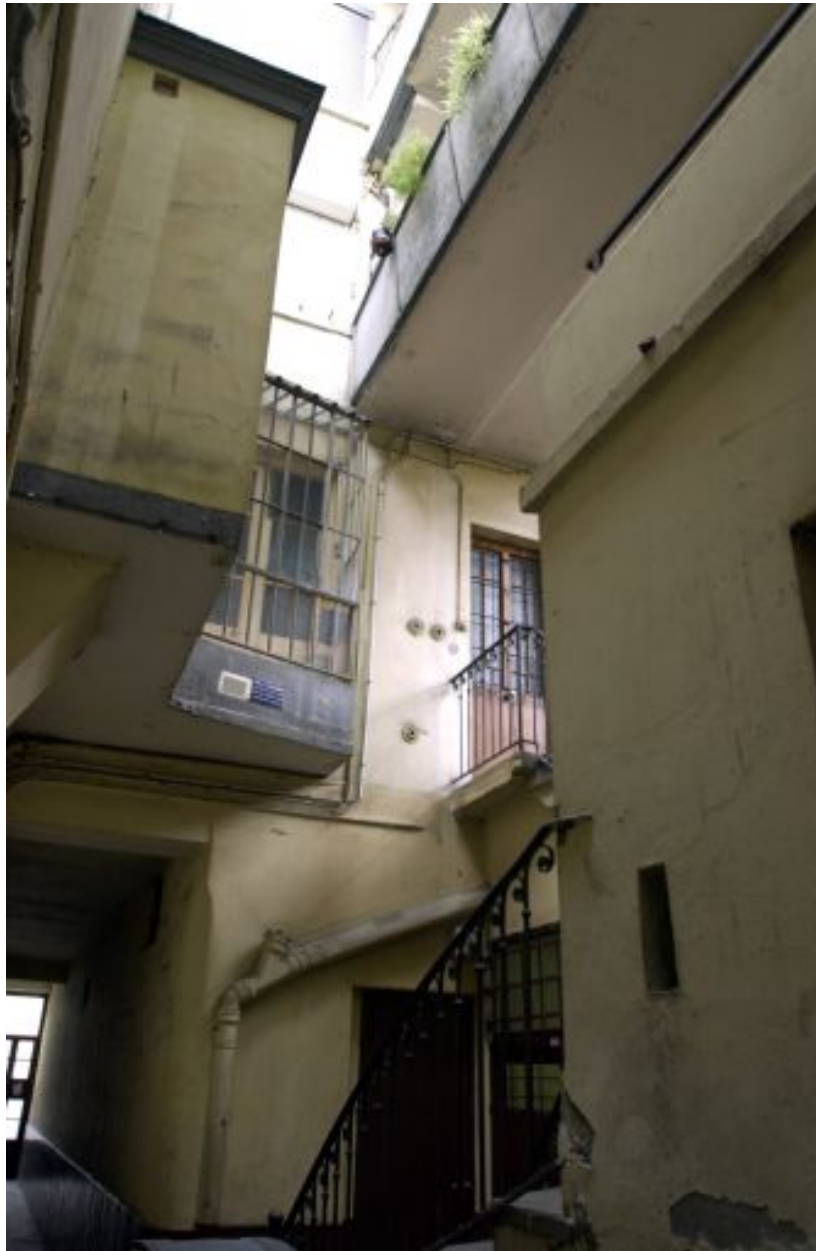
Elévation postérieure du bâtiment sur rue
