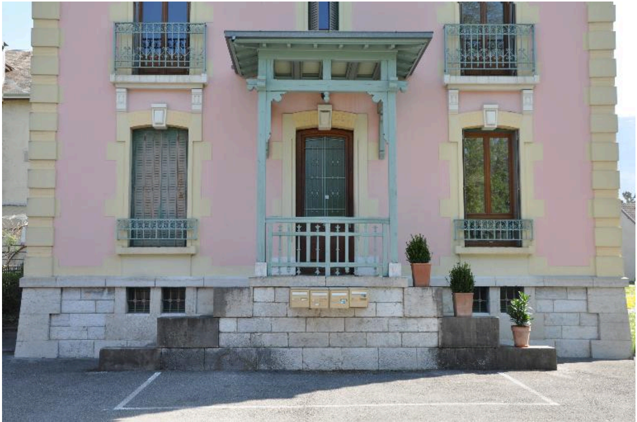
Porte d'entrée sur l'élévation ouest
