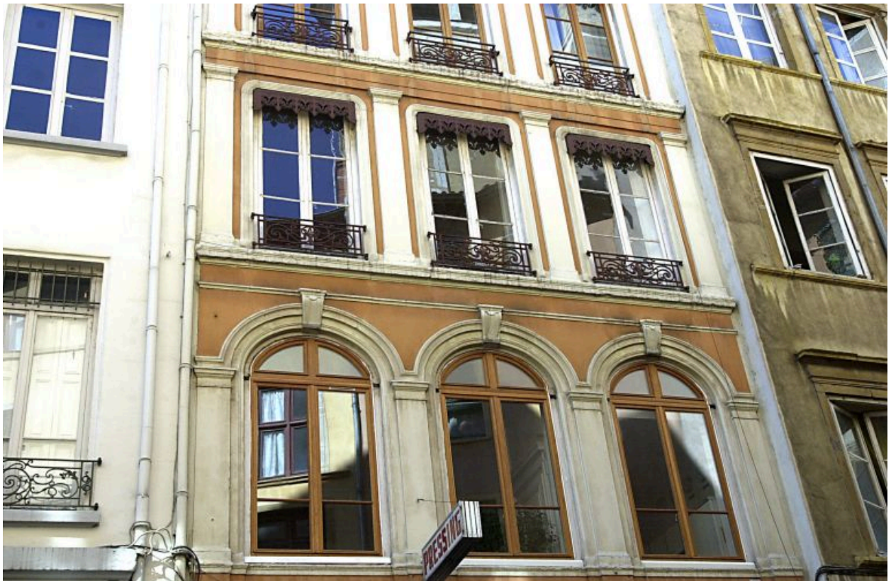
Façade sur rue, détail du 1er et 2e étage
