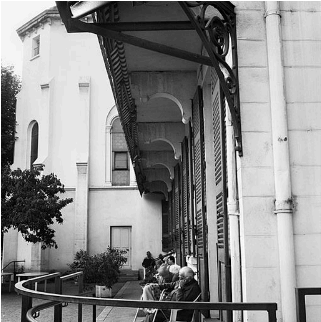
Façade sur cour, consoles soutenant le balcon du 1er étage
