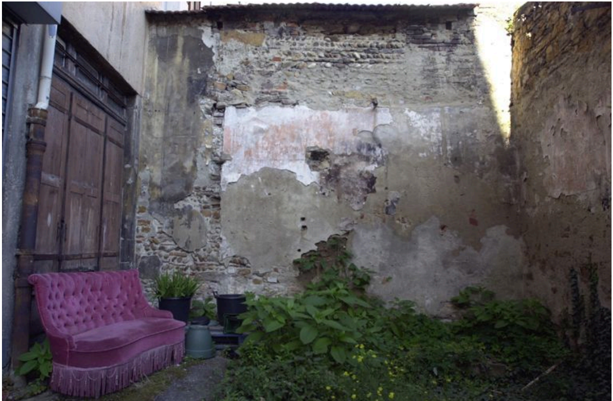
Cour, mur de clôture (mur ouest) en moellons et galets appareillés en arête de poisson
