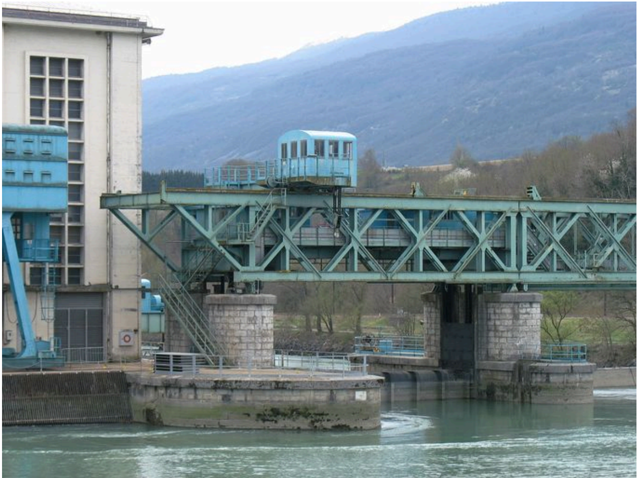
Barrage : vue partielle, face amont (nord)
