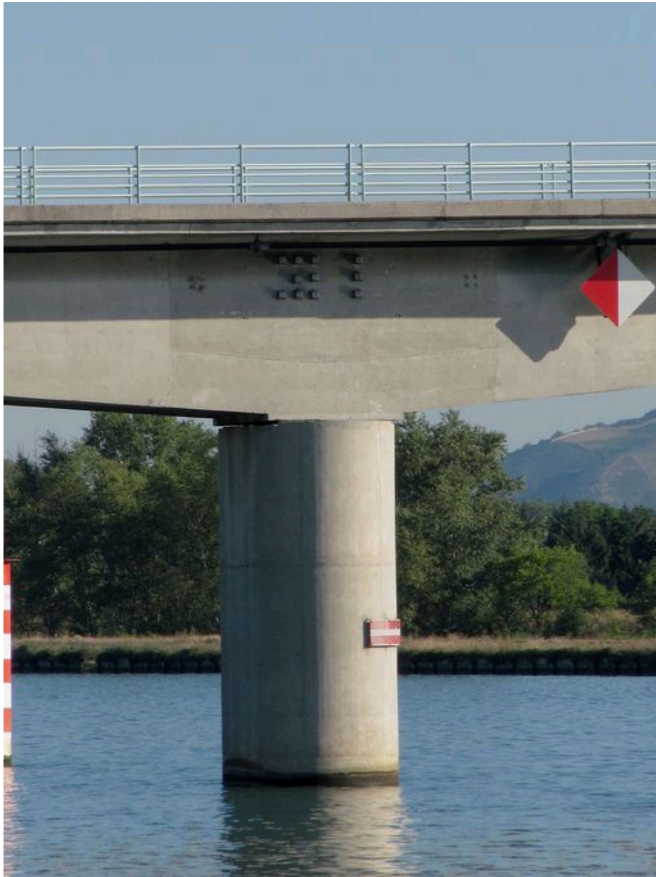
Pile, face aval (depuis la rive droite)
