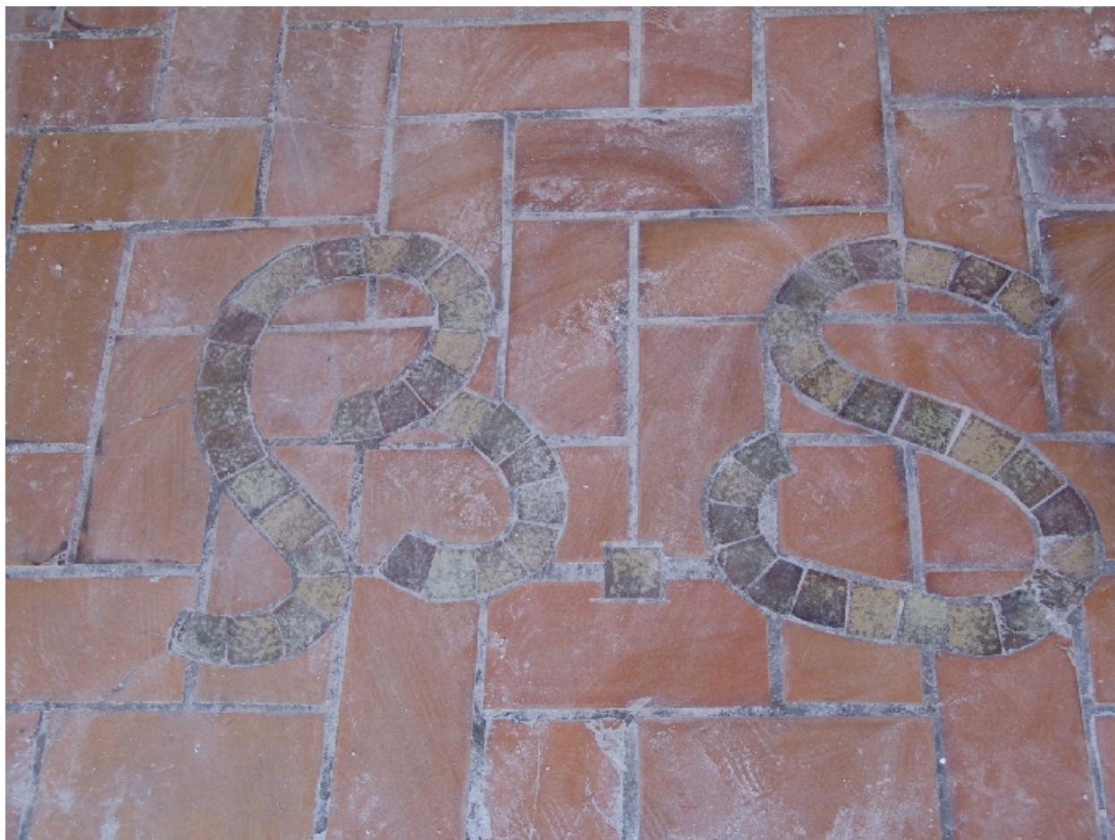
Détail du carrelage
