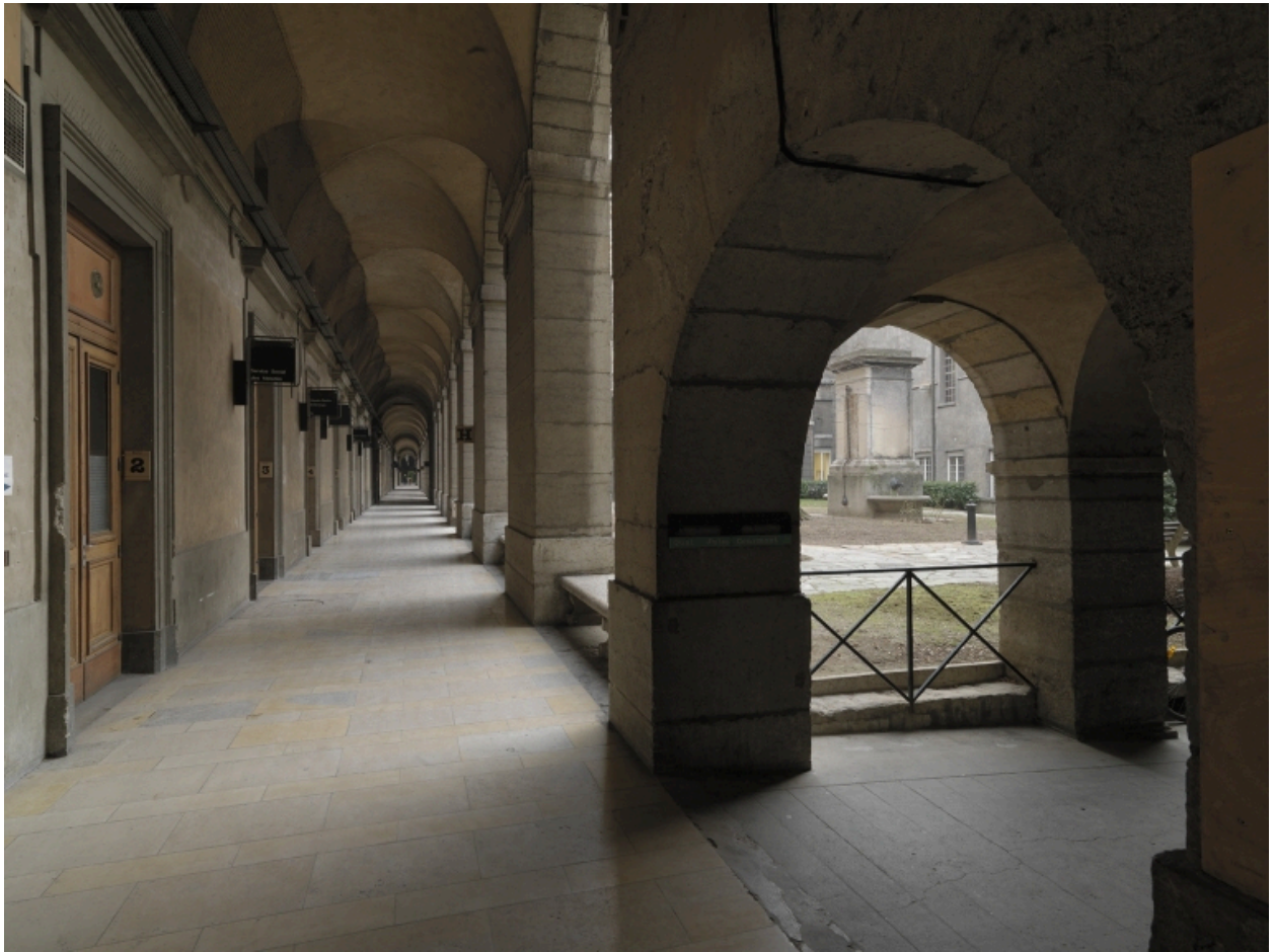
La galerie nord-sud le long des bâtiments du quai Jules-Courmont
