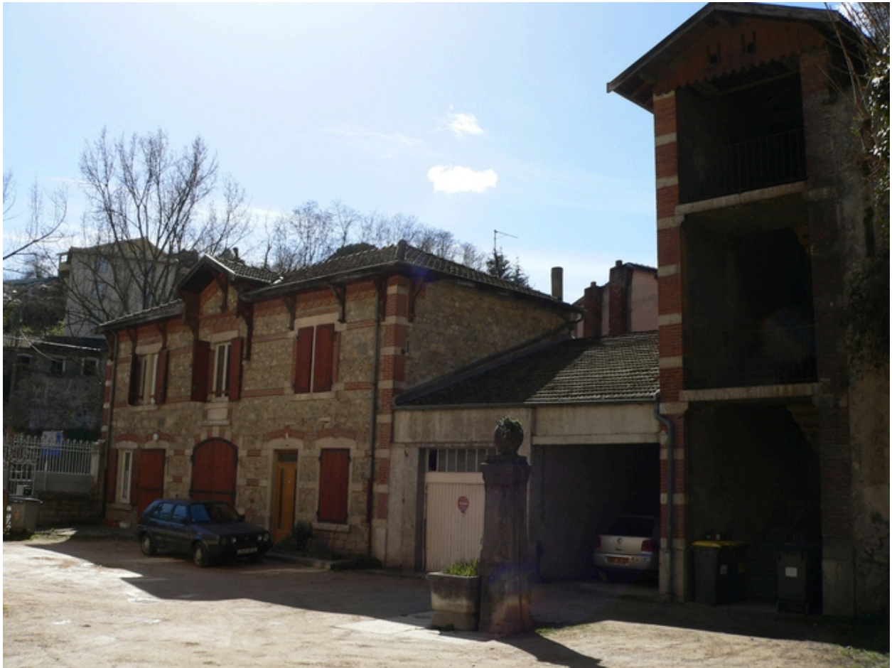
Façade sur cour
