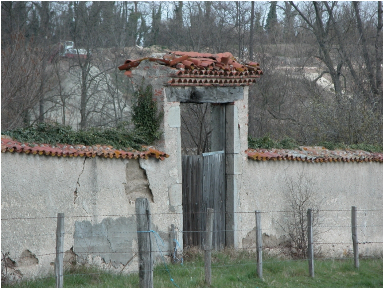
Vue d'un clos (murs en pisé) à Crémérieux (1997 AX 13). Détail du portail.
