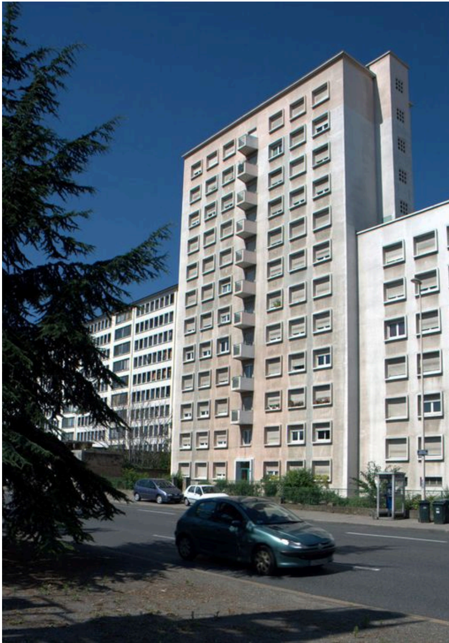
Immeuble n°66, vue d'ensemble depuis le nord-est
