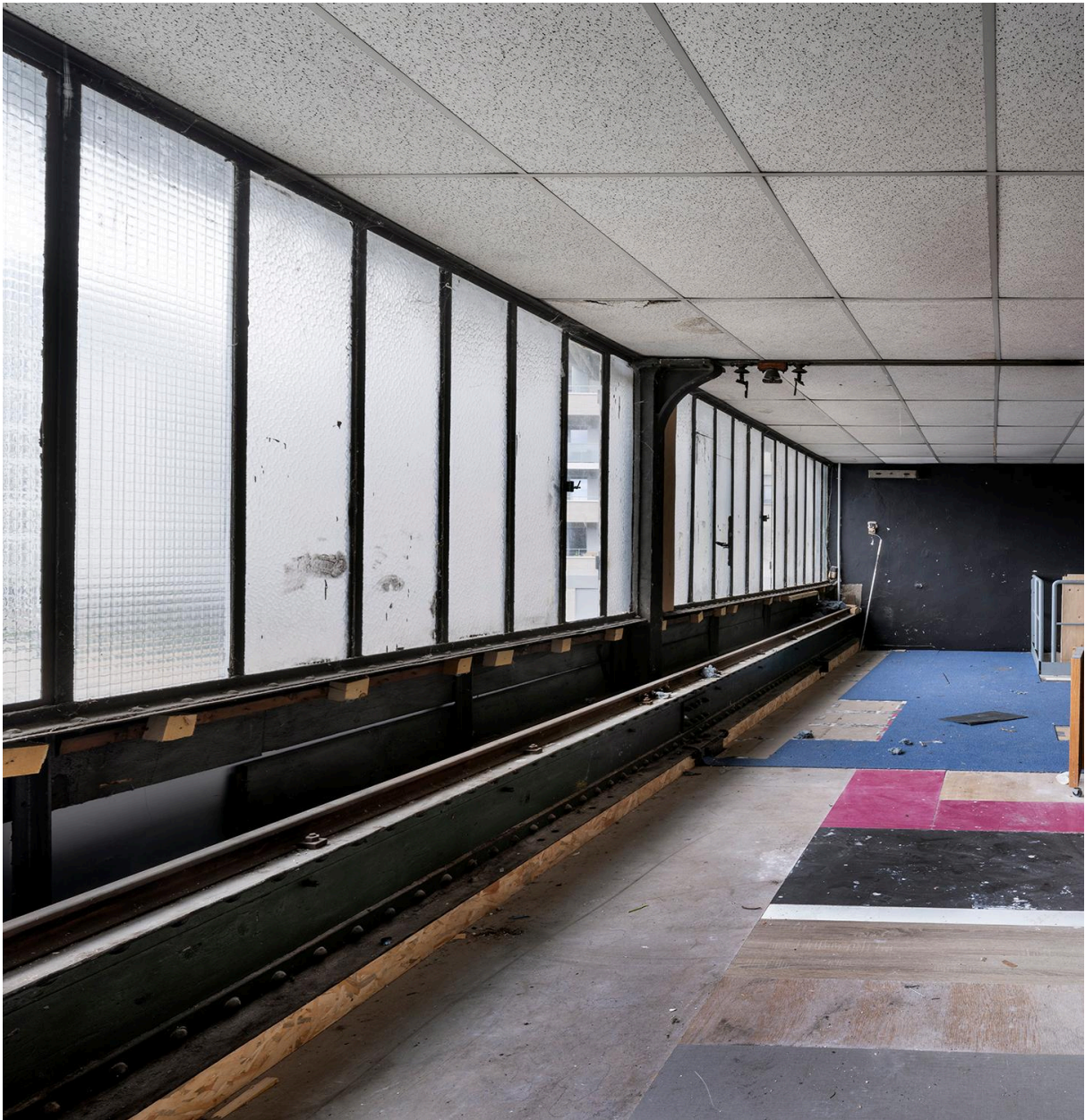
Vue intérieur niveau supérieur avant démolition
