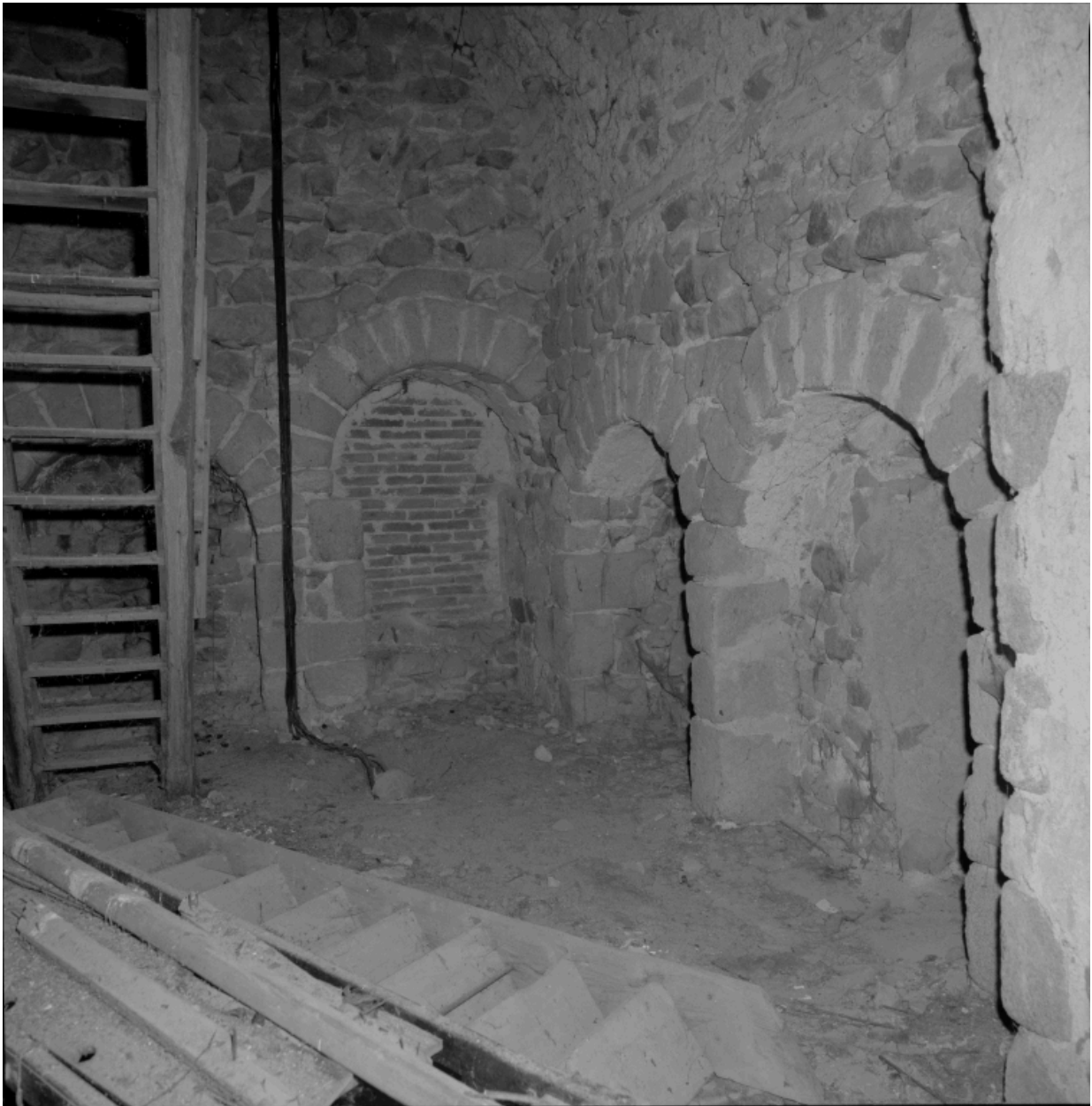
Vue intérieure de la salle haute du clocher : mur nord-est.
