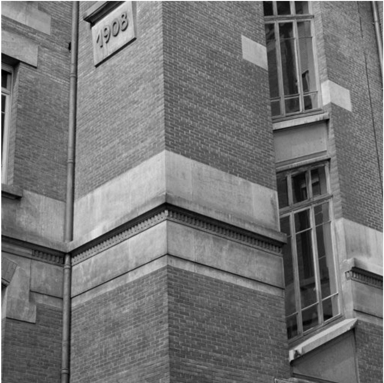
Bâtiment B, élévation nord de la cage d'escaliers secondaire, détails de la frise de briques en dents de scie et table
